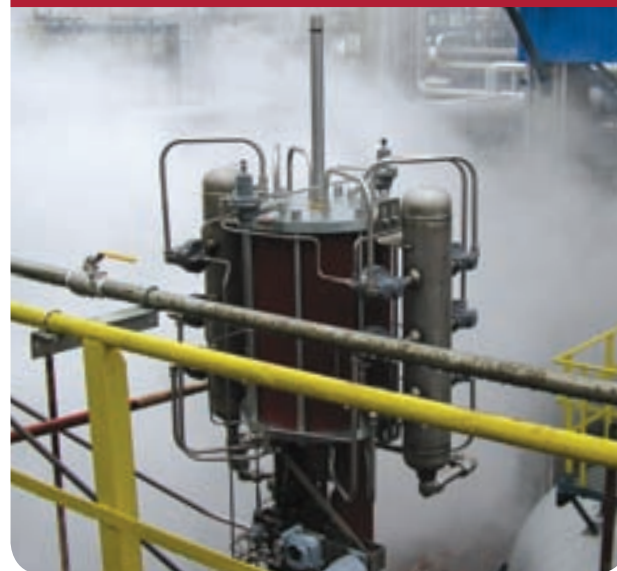
スチームコンディショニング向けコントロールバルブに取付けた場合
