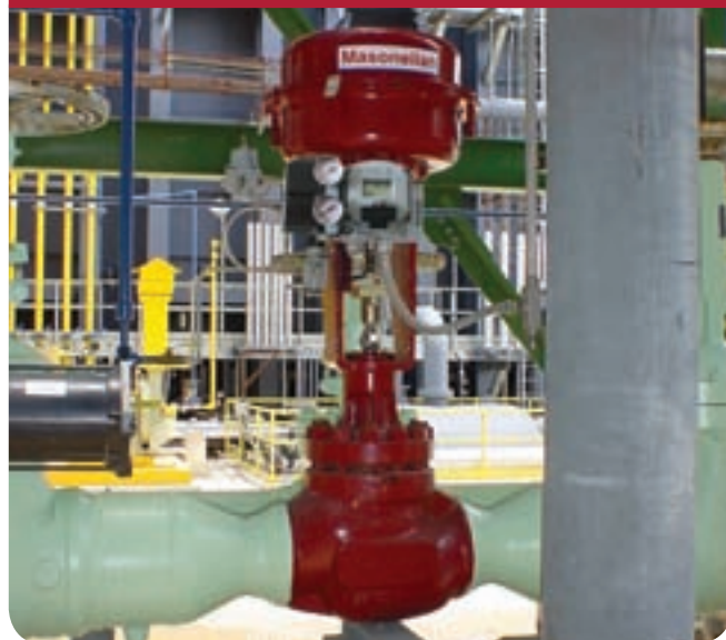
シビアサービス向けコントロールバルブに取付けた場合
